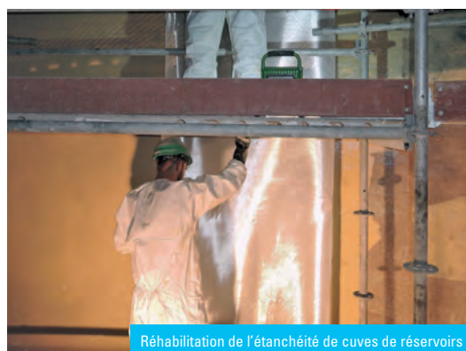
Réhabilitation de l'étanchéité de cuves de réservoirs
