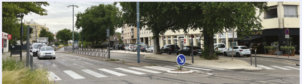
En amont de la création de la voie lyonnaise n°3 sur le boulevard de l'Europe de Pierre-Bénite, des travaux de restructuration électrique démarreront fin août.
